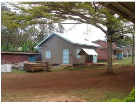
Das Powerhaus mit dem Notstrom-Generator
