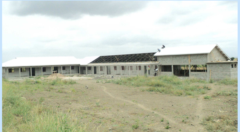
Der Rohbau Mitte Juni 2013
