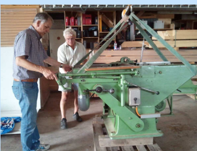
Soweit es möglich ist, sind die Maschinen zu demontieren. Hier die Hobelmaschine.
